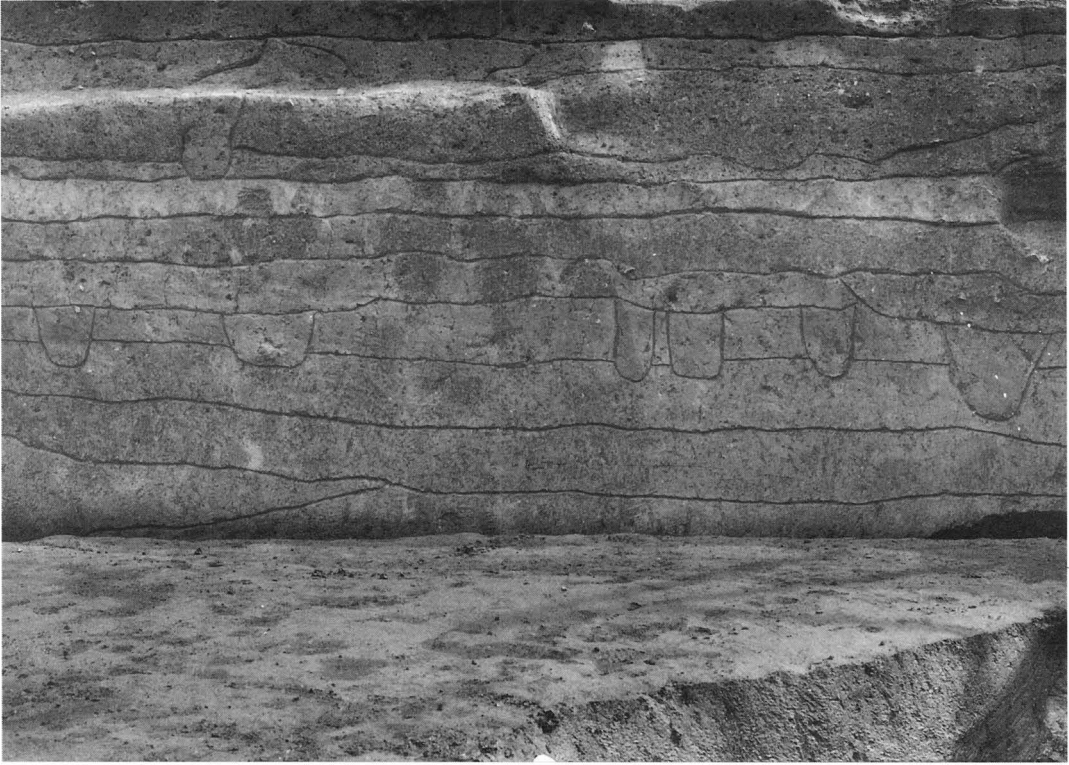
第2調査区南壁断面（北より）
