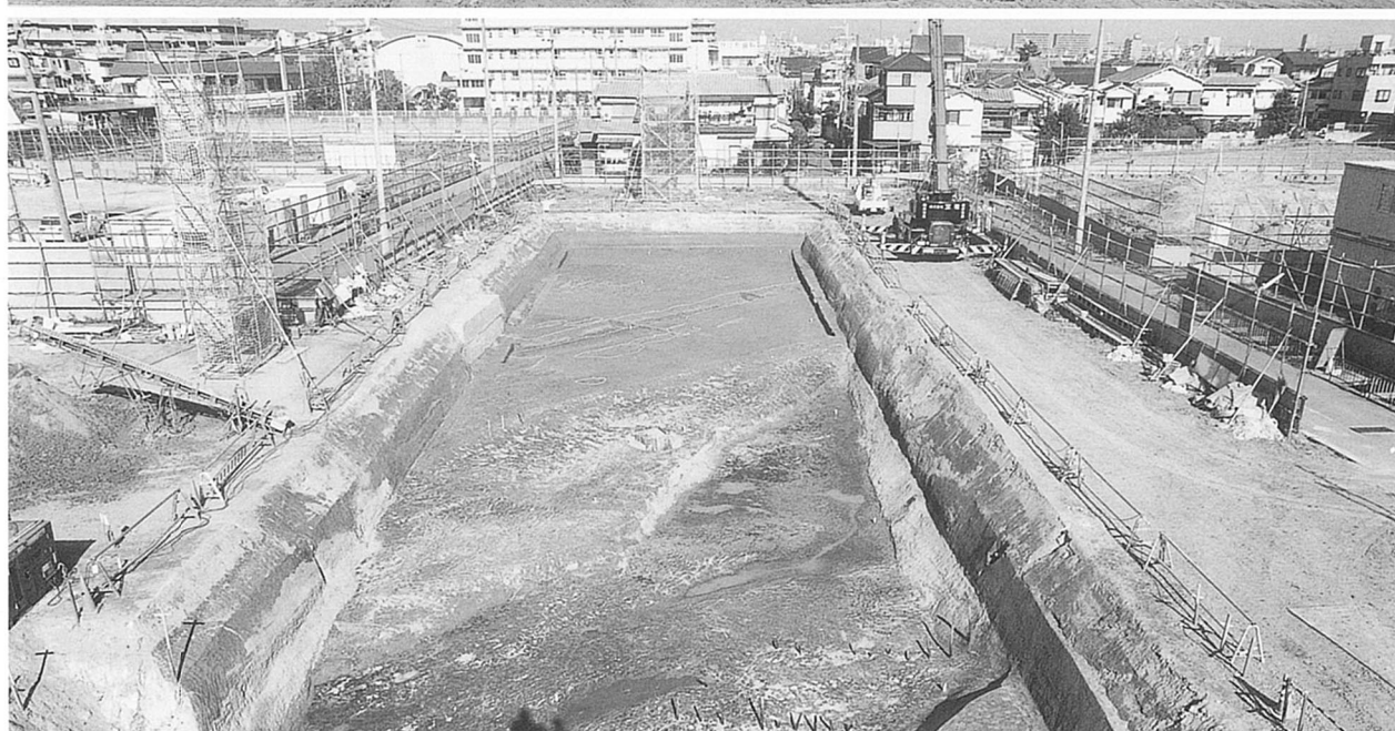
上 1Dトレンチ (南から) 中 3Dトレンチ (南から) 下 6Dトレンチ (南から)
