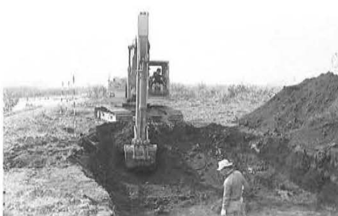
トレンチ掘削状況
