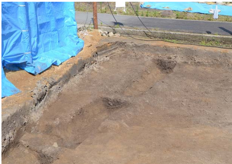
1、5-1区 SD605 掘削状況（西から）
