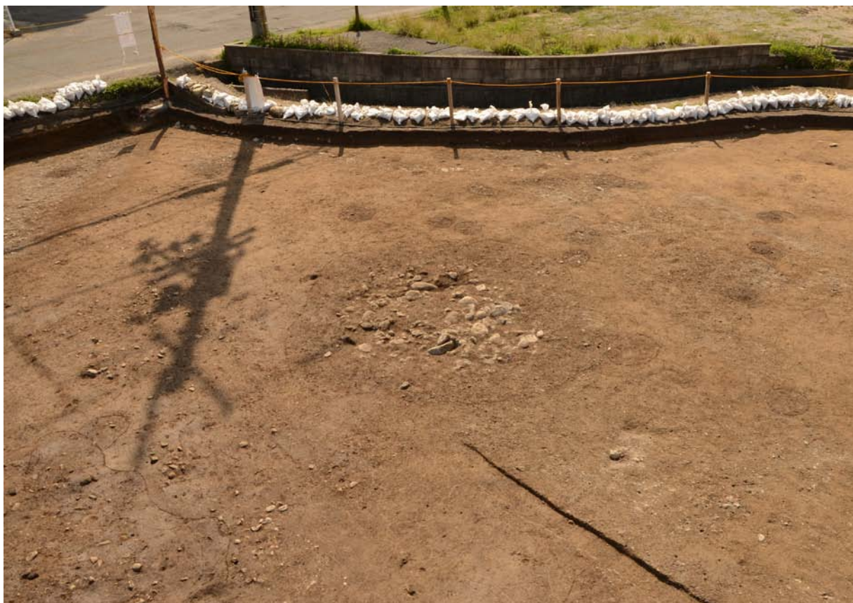
1、5-1区西側検出状況（北東から）
