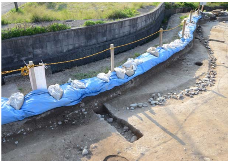
2、5- 1区 SD602 上層掘削状況 (東から)
