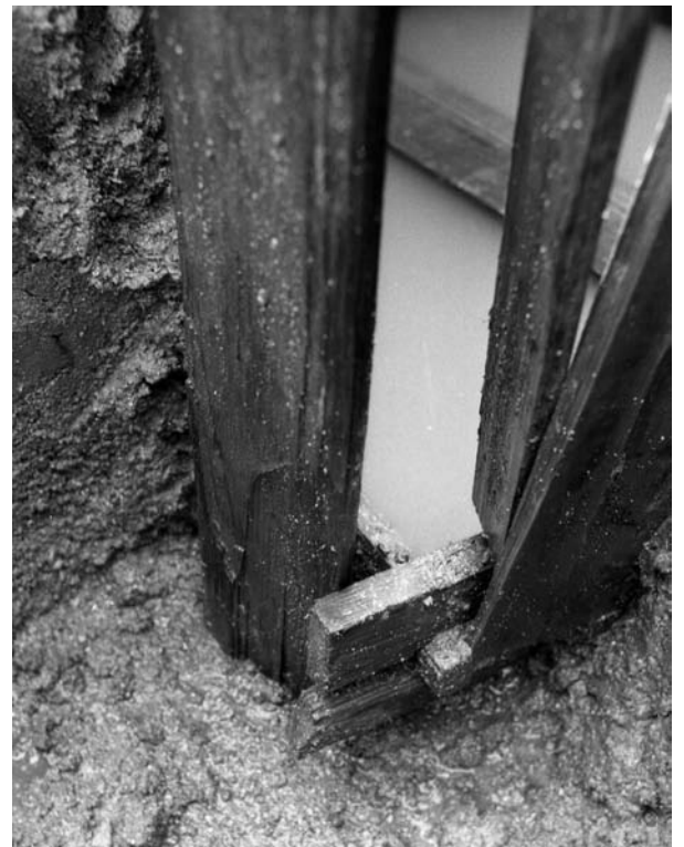
69.SE79001 縦板と横木の組合わせ状況
