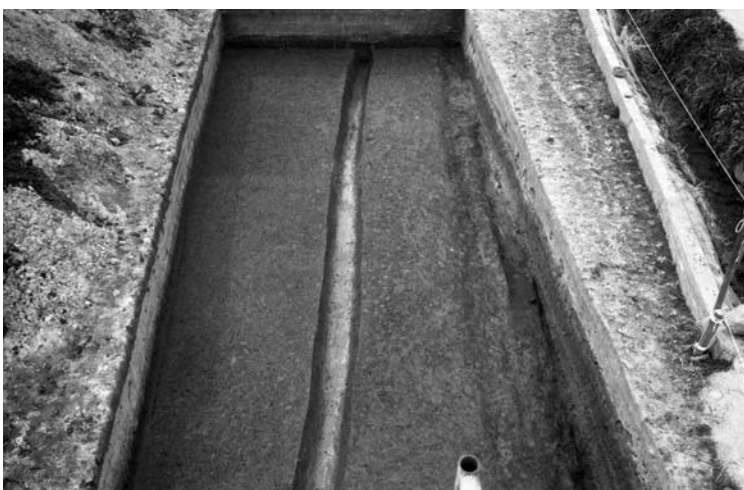
104.A6・A7SD81008 下層完掘状況 東から
