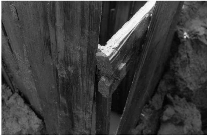
70.SE79001 縦板と横木の組合わせ状況
