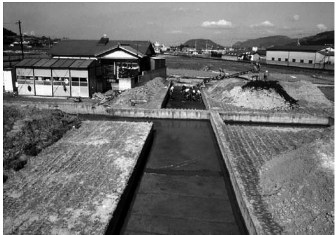
写真 51 8 次調査地北半部全景 南から
