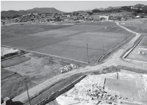
J18区 石器集中部1・南西方向拡張部 完掘状況・作業風景 南から
