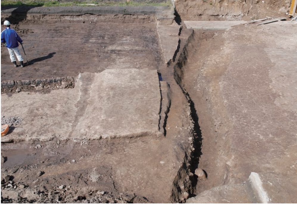
I区 SD07北半完掘状況 南から
