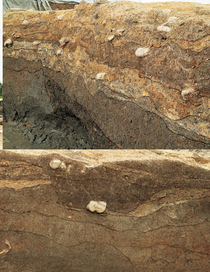
大極殿後方基壇の積み土（北東から） ※黄橙色砂質土と暗褐色砂質土を版築状に積み上げる 積み土には礫が多く含まれる
