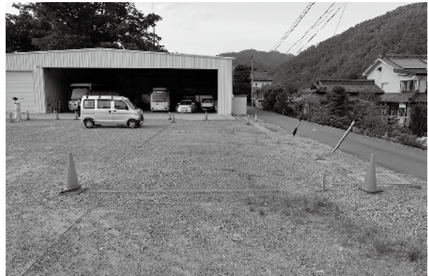
調査前近景（南から）
