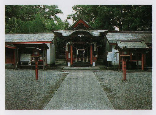
20. 指宿神社 本殿・舞殿・拜殿・勅使殿 平成4年3月2日 市指定
