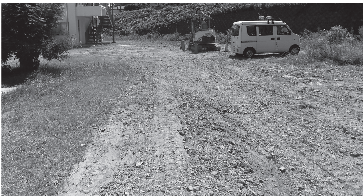
調査地埋戻し完了状況 (北から)
