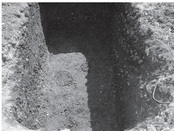
G 4 全景 (北から)
