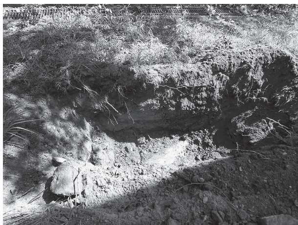
G1 埋設管検出状況 (南から)
