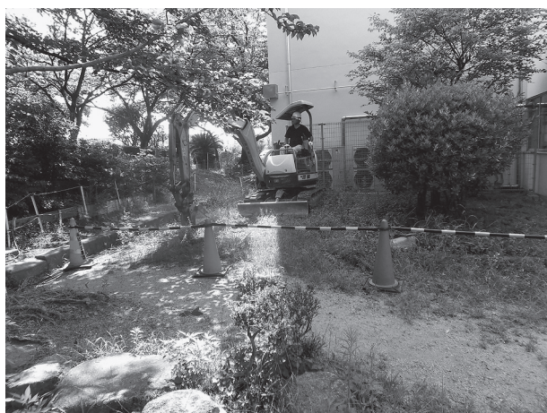
G1 機械掘削状況 (西から)
