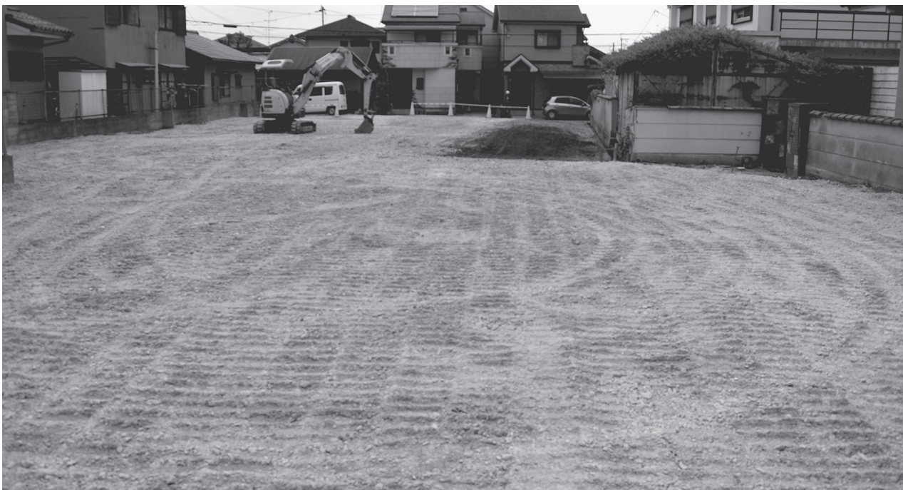
調査地埋戻し完了状況 (西から)
