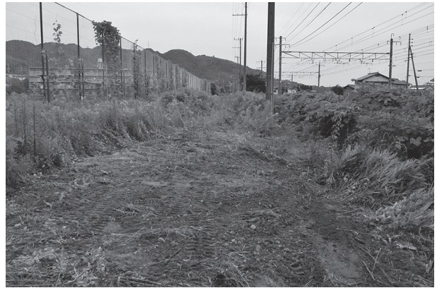
第2・3調査区埋め戻し状況 (南から)
