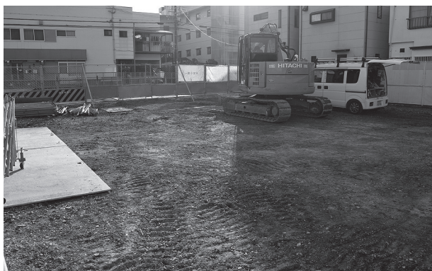
調査前風景 (北西から)
