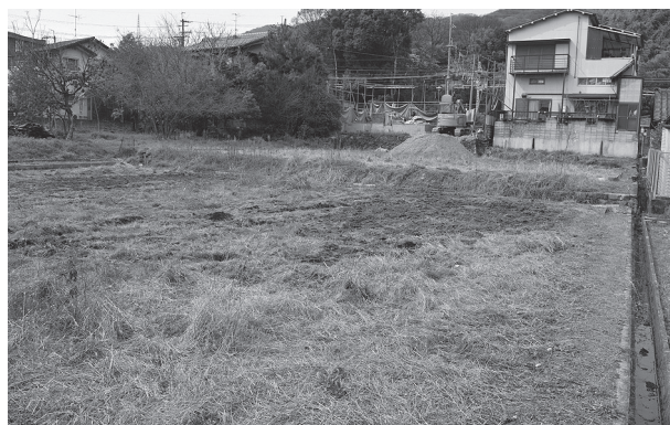
埋め戻し状況 (南東から)
