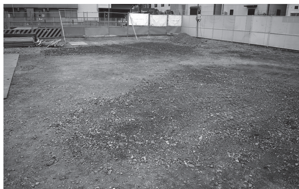
埋め戻し状況 (北西から)
