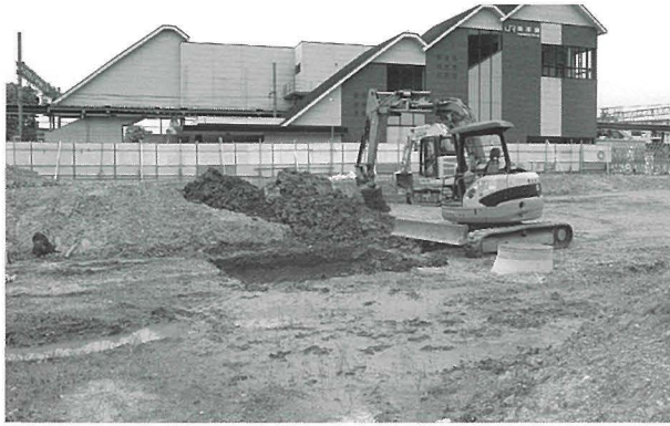
調査地近景 (西から、第1グリッド付近)
