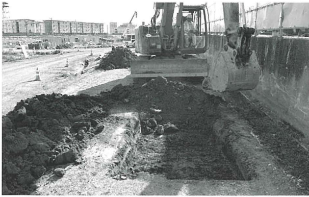
第5グリッド機械掘削状況(北から)
