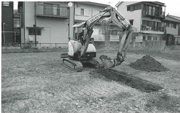
北グリッド機械掘削状況 (南西から)
