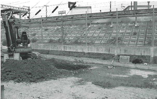
調査地近景 (西から、第2グリッド付近)
