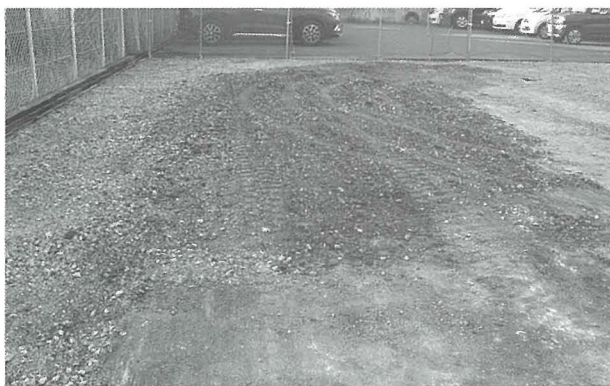
調査区埋戻し状況 (南から)
