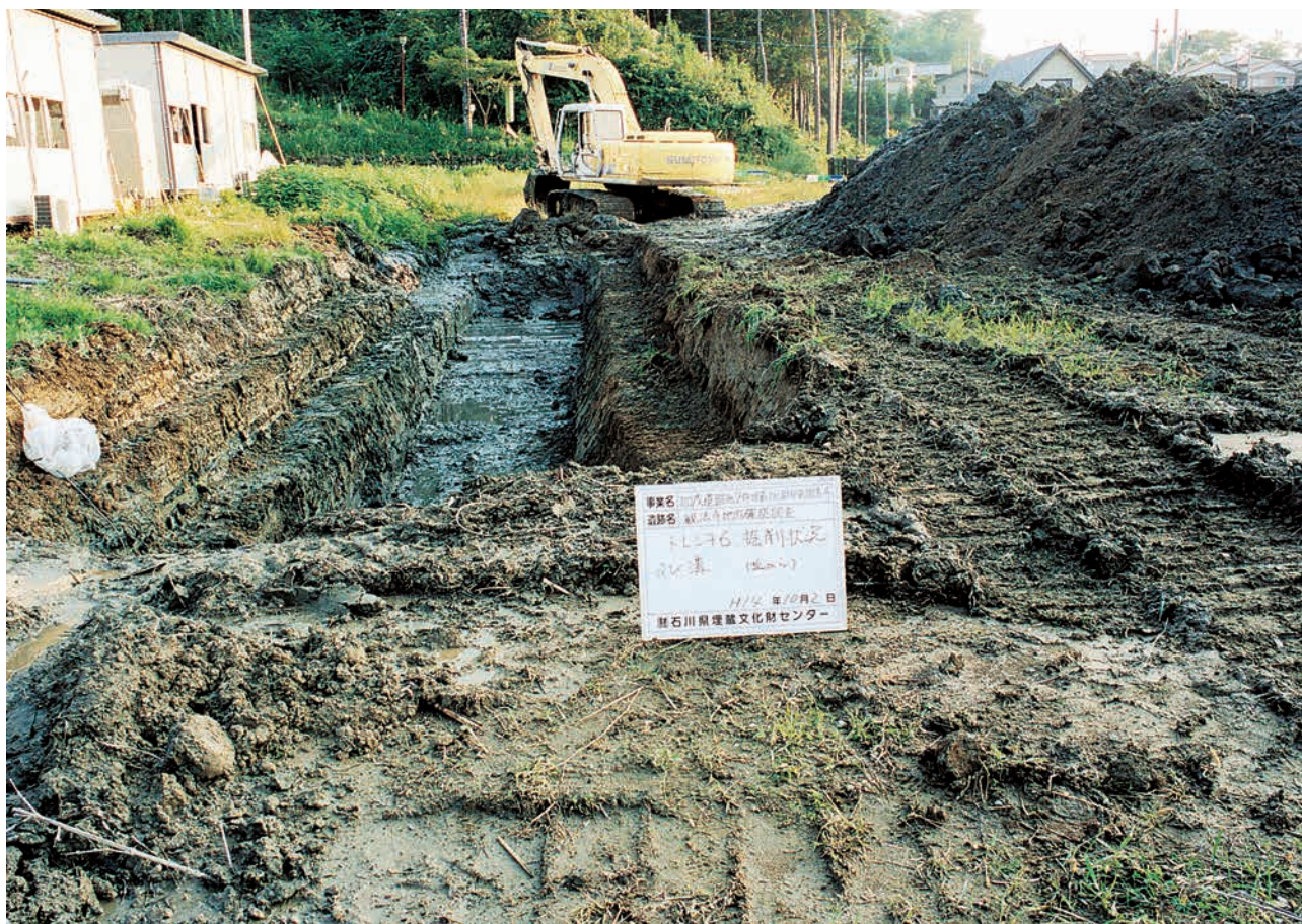
トレンチ6 掘削状況
