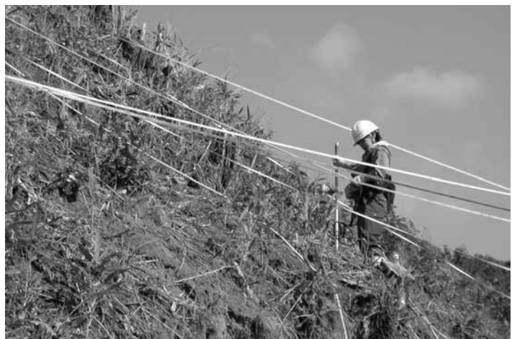
磁気探査の様子
