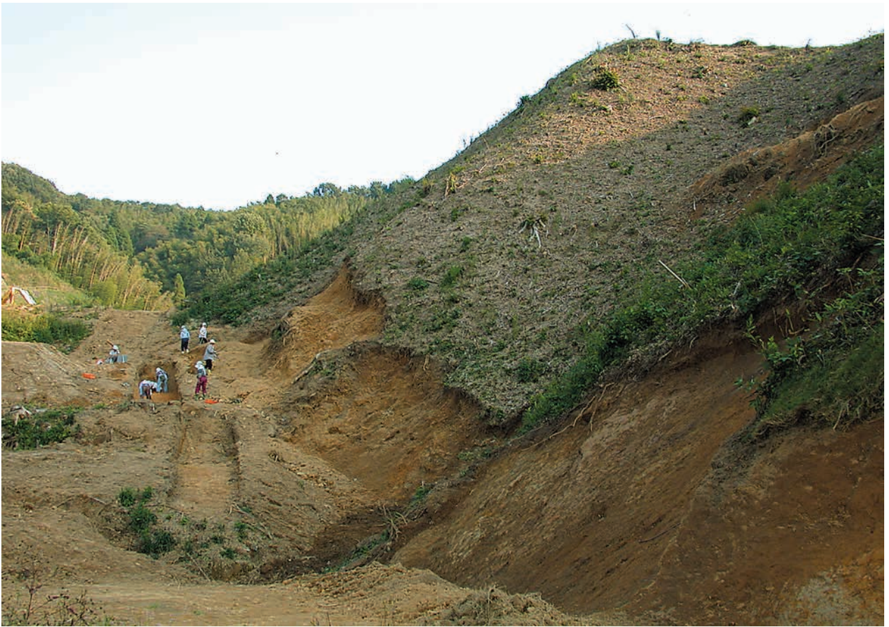
トレンチ9 遠景
