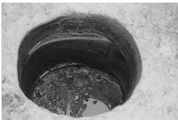
M1区SE17井側内
