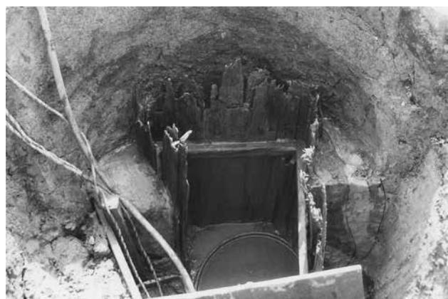
V1区SK03断ち割り
