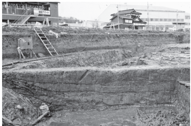
4号溝 土層断面 (南東から)
