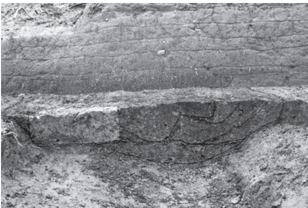
SD02 土層断面 (西から)
