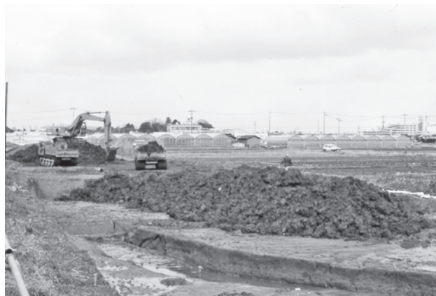
調査区埋め戻し作業 (南西から)
