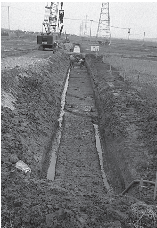
1～3区 完掘状況（北東から）
