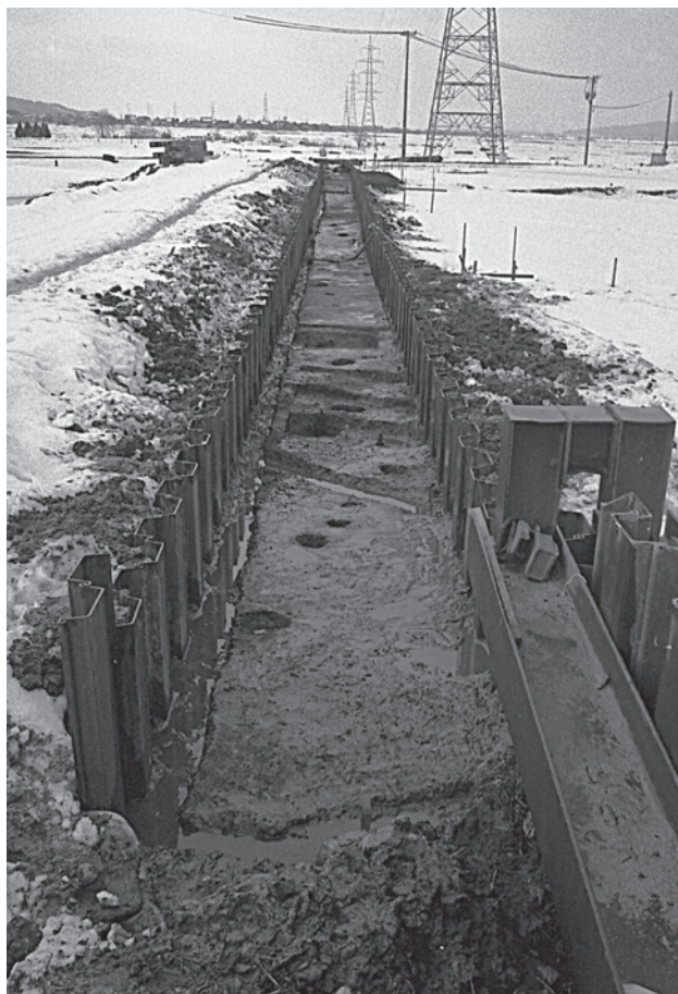
7～14区 完掘状況（北東から）
