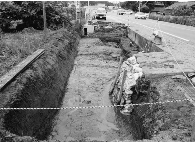
調査区全景（南西から）
