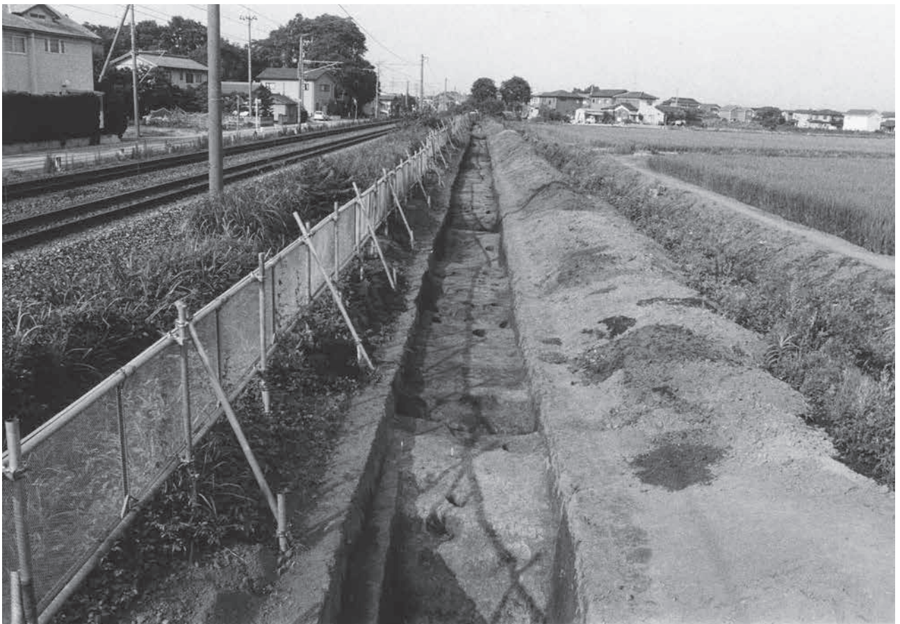
完掘状況全景（南西から）
