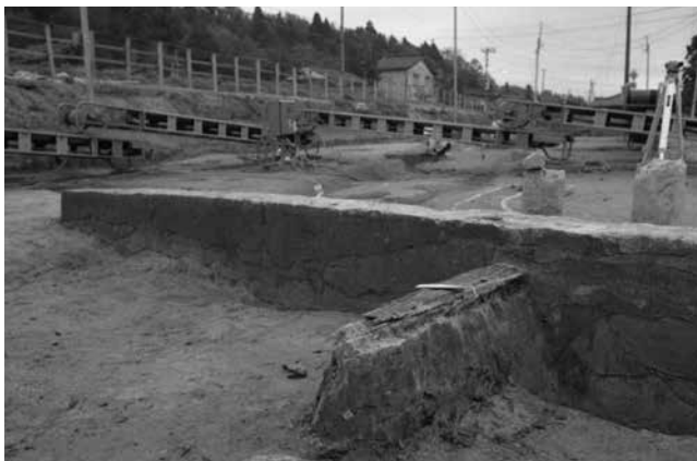
盛土部土層断面 (東肩部)
