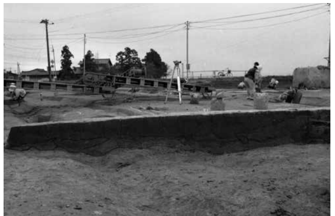
盛土部土層断面 (東肩部)
