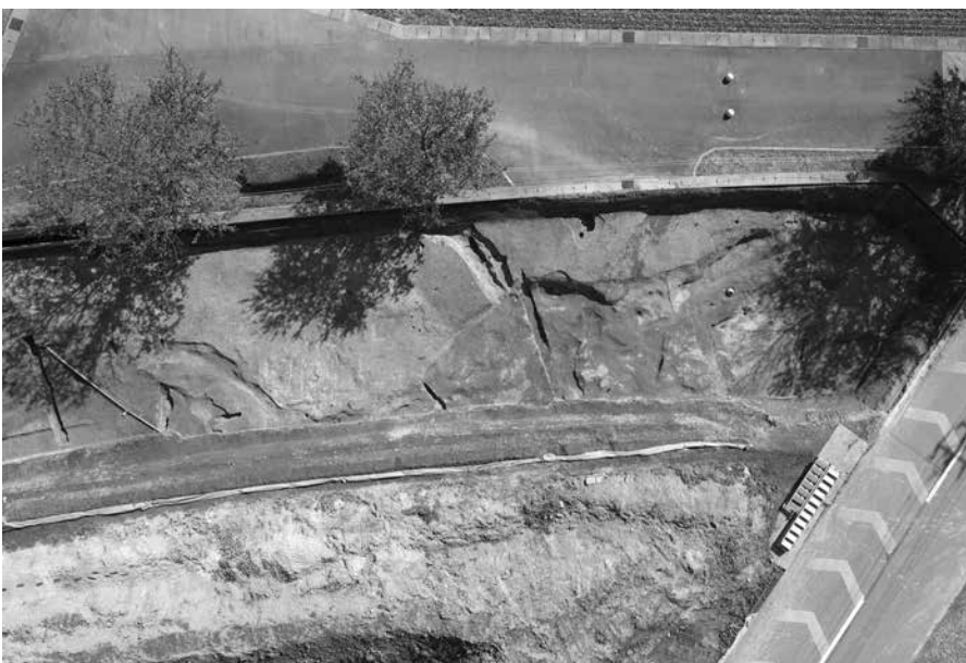
調査区南西側(俯瞰)
