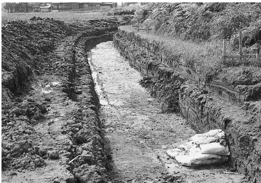
張り出し部北側完掘状況
