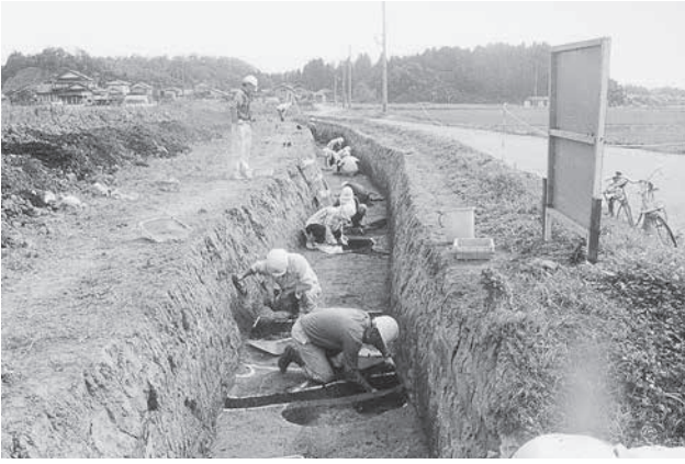
3区南部作業風景（北から）
