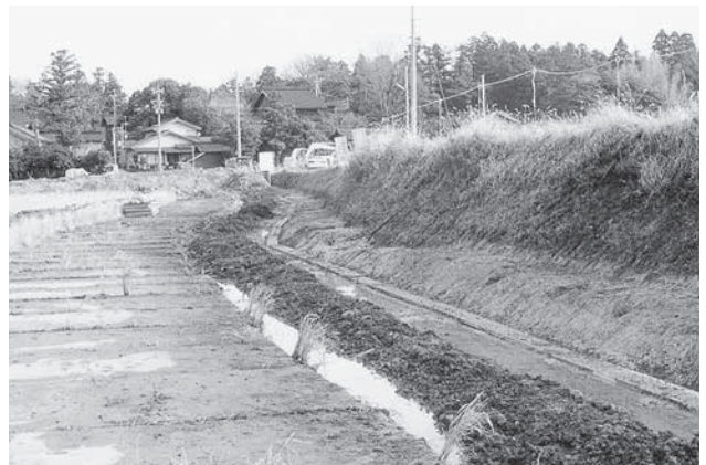
1区完掘状況（南西から）
