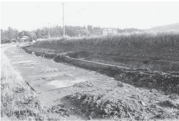
1区完掘状況（南西から）
