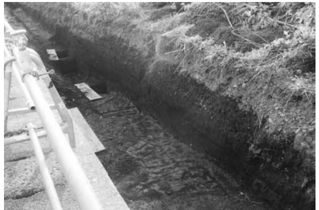
4～6区完掘状況（北東から）
