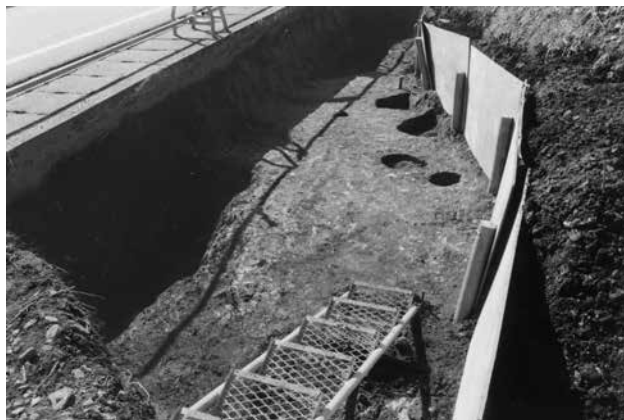
1～2区完掘状況（北東から）
