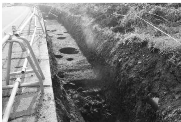
2～3区完掘状況（北東から）
