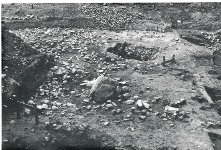
図版 9 遺物出土状況
