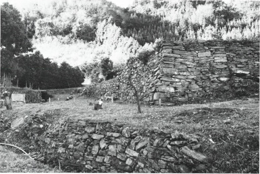
北・東側外石垣（北より）
