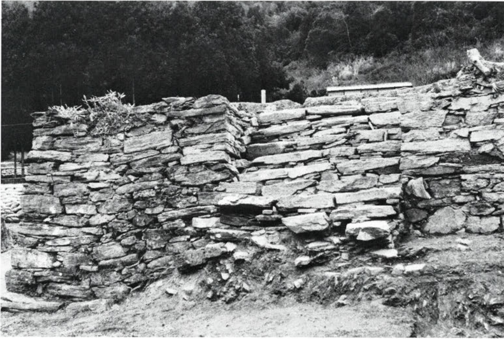
北側外石垣東階段（北より）
