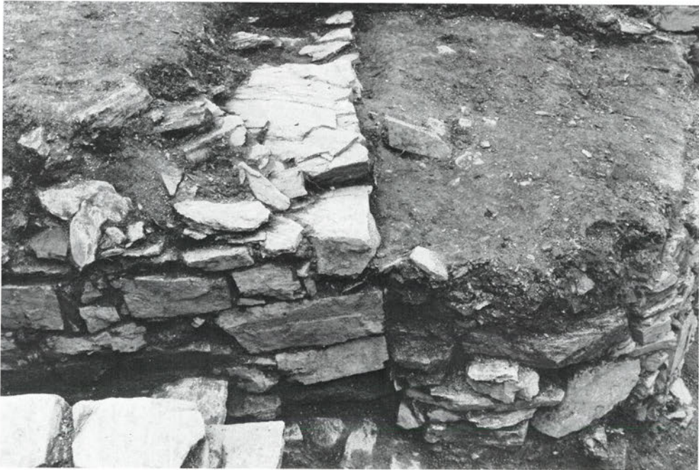
石垣拡張状況（東より）
