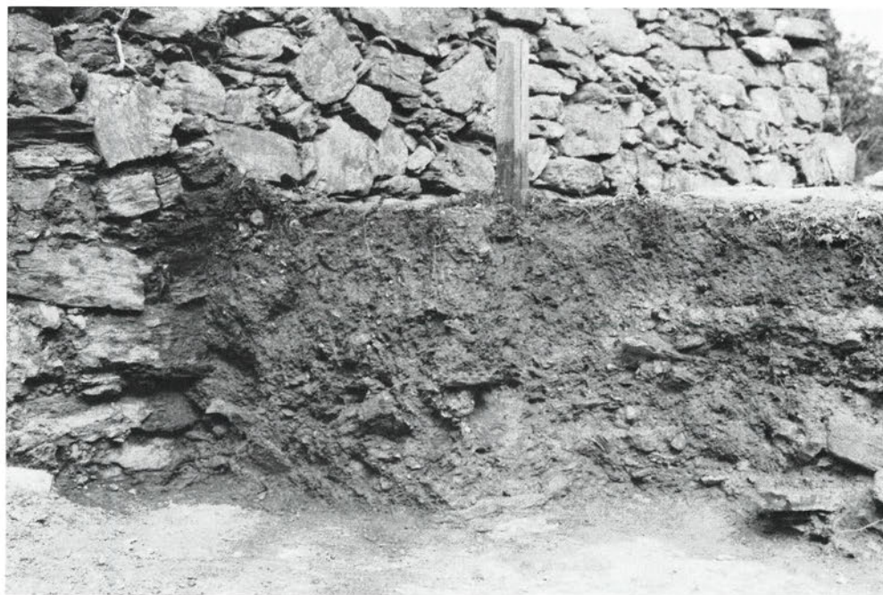
東側外石垣（東より）
