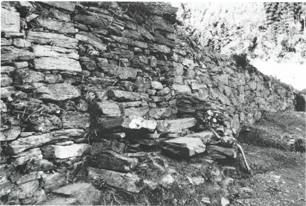
北側外石垣東階段（北より）
