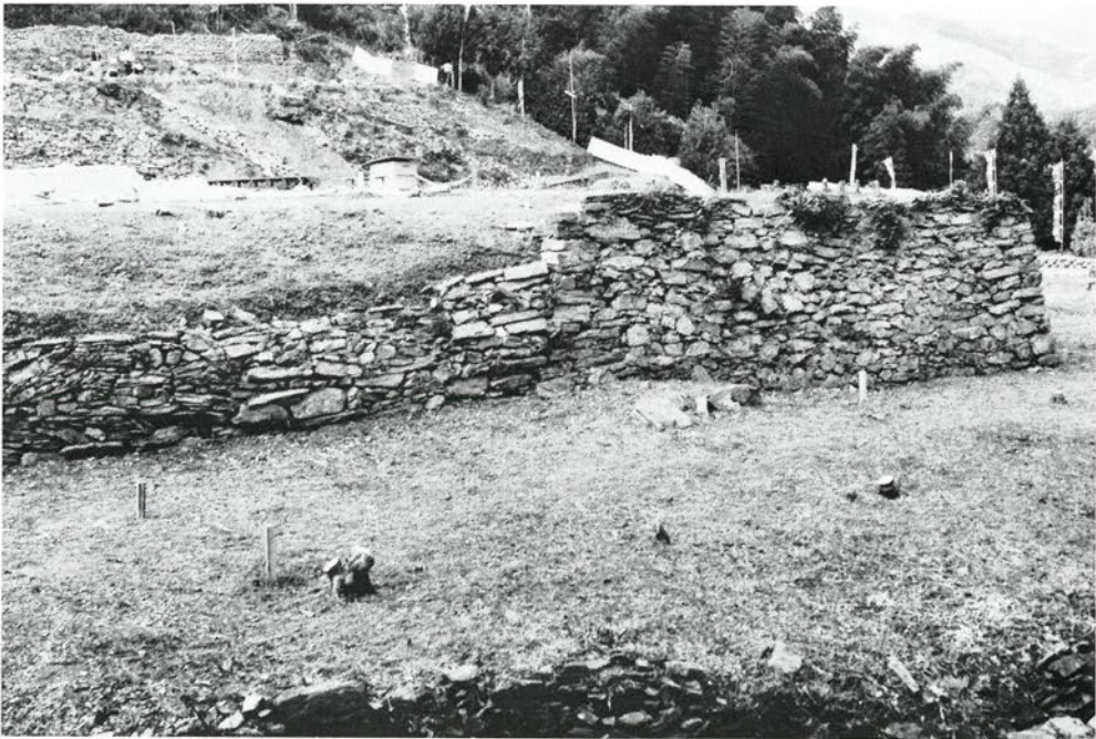
東側外石垣（東より）
