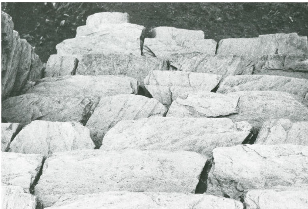
北側外石垣東階段（南より）
