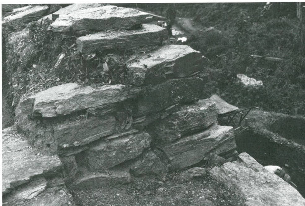
東側外石垣拡張部（南より）
