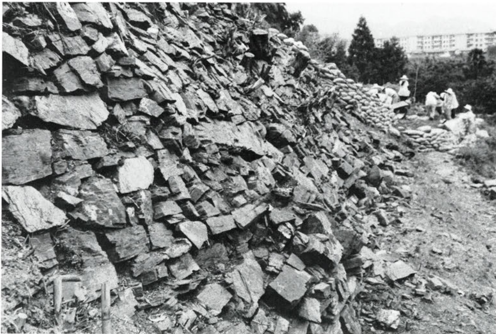
55-8 番地南北石垣 (南より)
