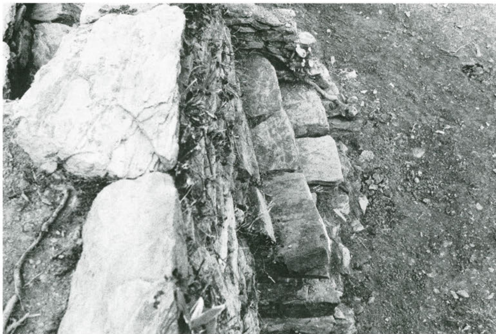
北側外石垣東階段（東より）
