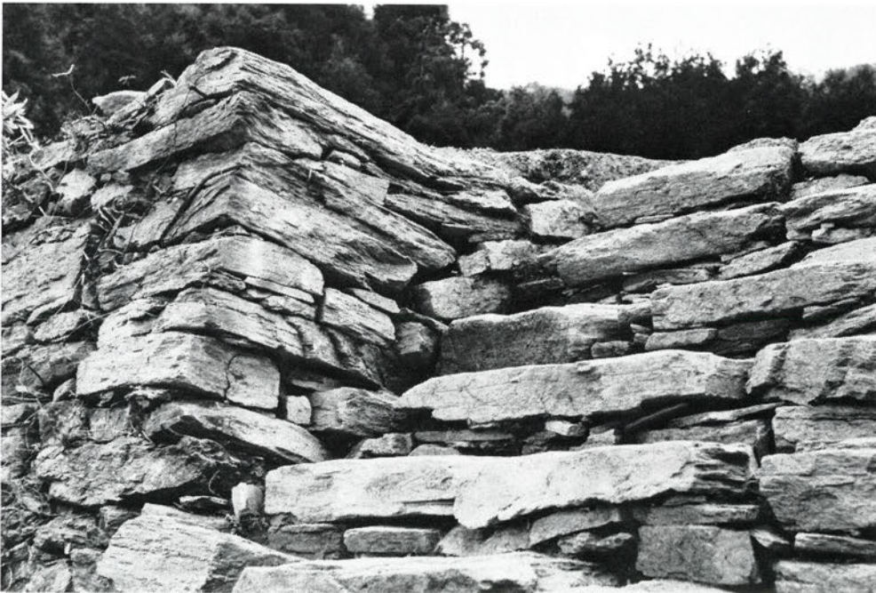
北側外石垣東階段（北より）
