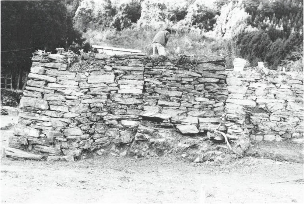
北側外石垣東階段（北より）
