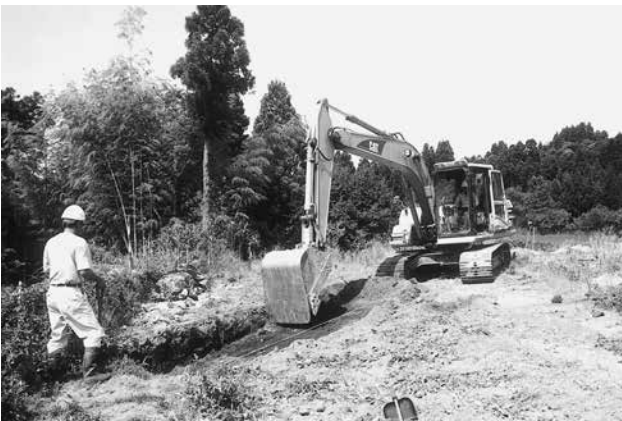
東西排水路調査区表土除去風景
