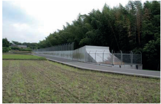
写真10 W・E区現況（西から）
