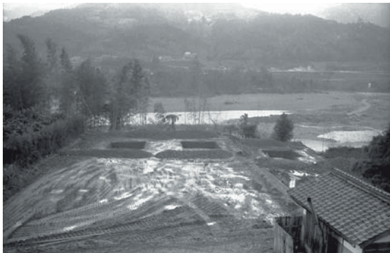
写真13 E区掘削状況（北から）
