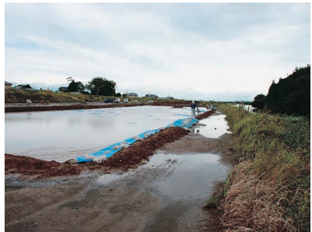
写真8 21年台風18号による被害
