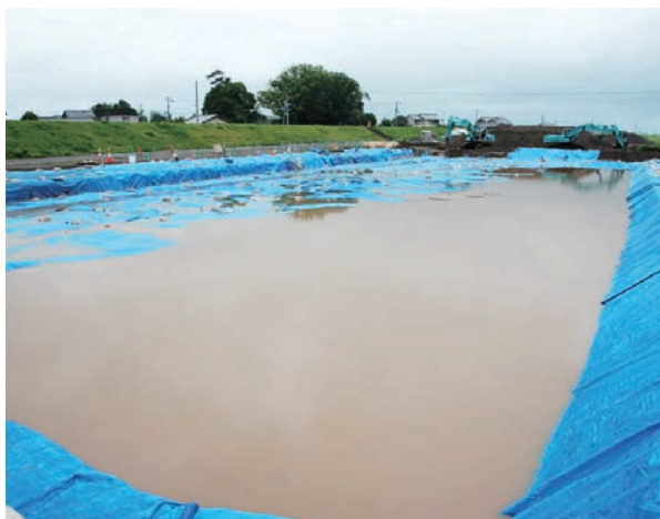
写真4 21年7月豪雨の被害
