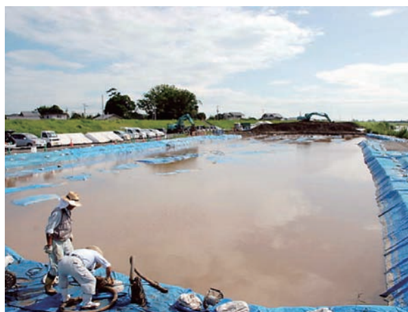
写真6 21年台風9号による被害
