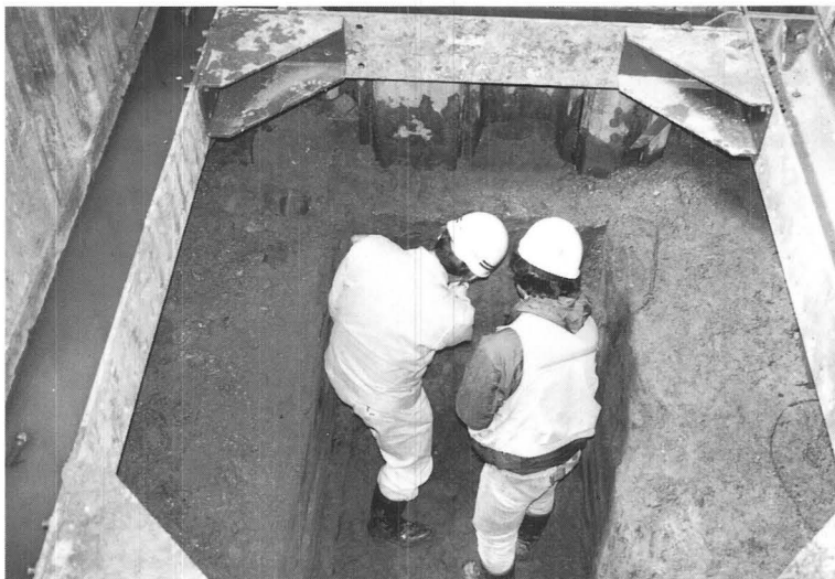
1. C地区調査風景
