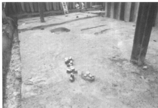
図3.32 第3回検出面北部(北西から) 土器が集中している部分が土器群312。溝302は 掘削途中の状態である。
