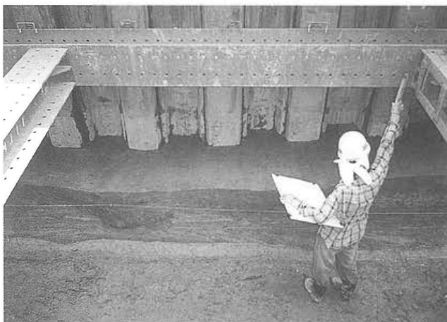
写真3 弥生时代前期遺構面断面と調査風景
