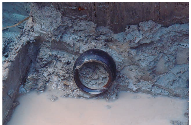
同 遺物出土状況 (東から)
