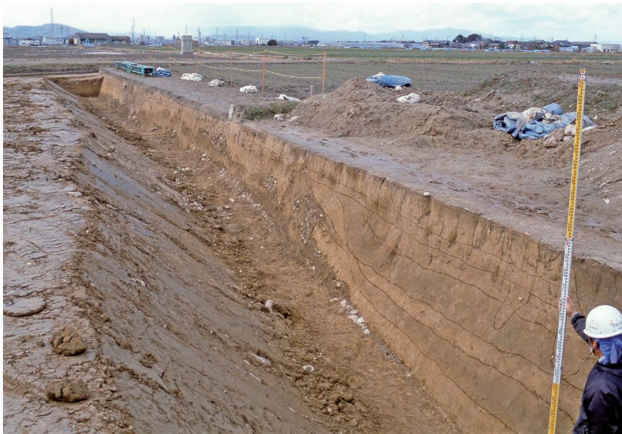
6区北壁西側下層確認 (南東から)
