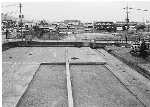
2 A-1区 第2遺構面 全景 (北から)
