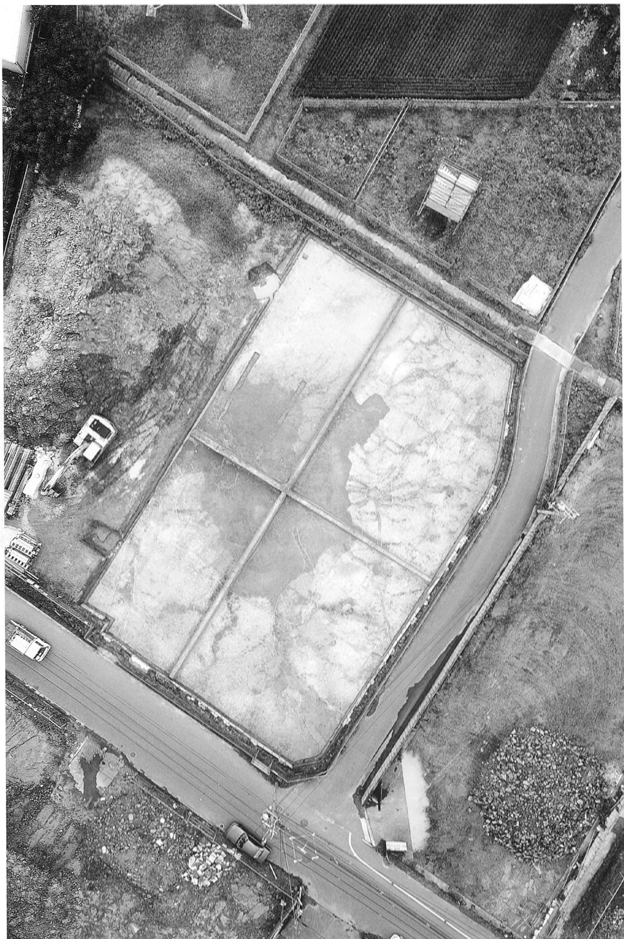
1 A-1区 第4遺構面 全景〔1〕 (右上が北)
