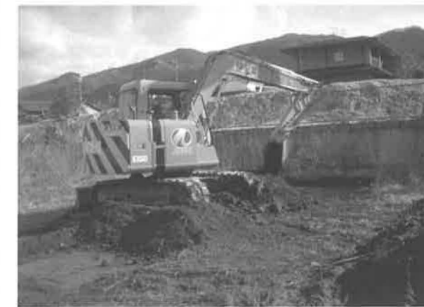
図1.3 調査地西半部での機械掘削の様子。
