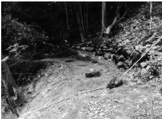
写真46 トレンチ掘削状況 南西から
