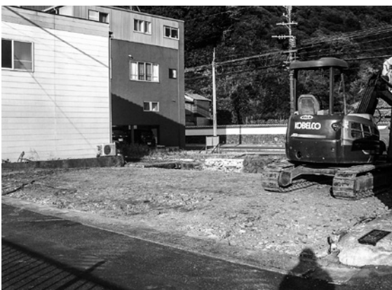
写真18 T5・T6掘削前 南東から
