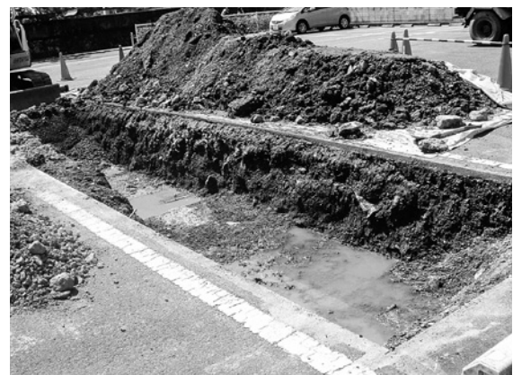
写真21 T2完掘状況 東から
