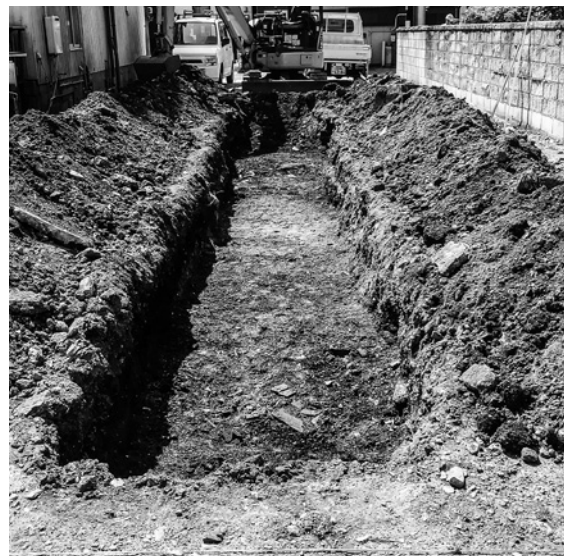
写真41 T1完掘状況 北から
