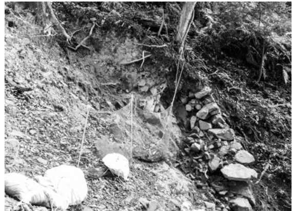
写真34 雌池背後の石垣清掃状況 北西から
