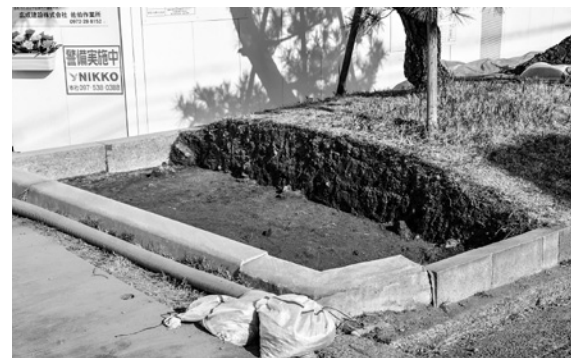
写真58 掘削状況全景 西から
