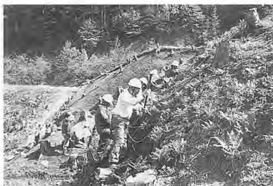
9号切岸作業風景
