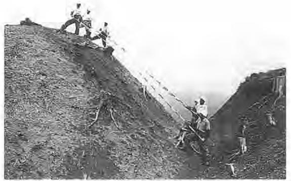
5号堀実効法高検証風景
