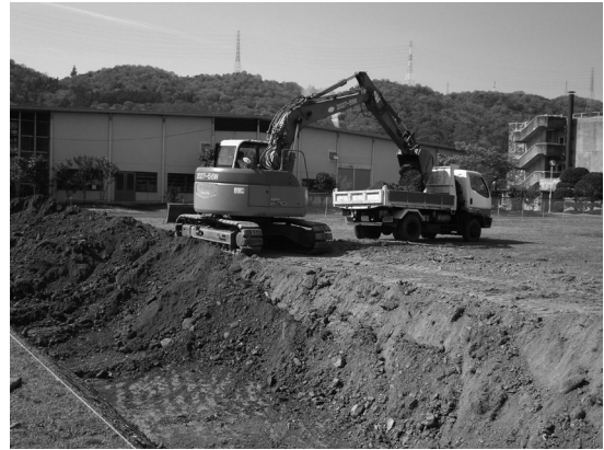
写真 1 機械掘削作業
