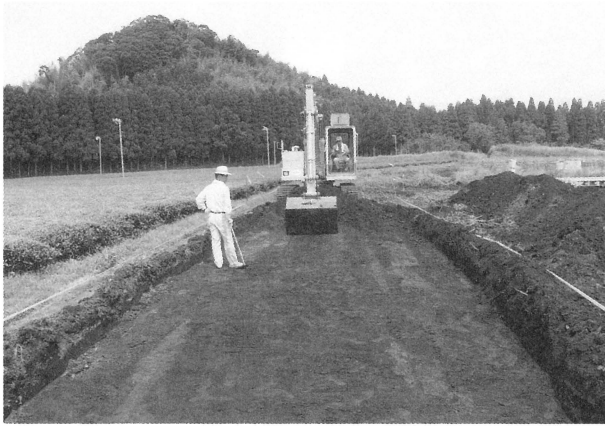
写真Ⅱ.01 調査状況（表土除去）
