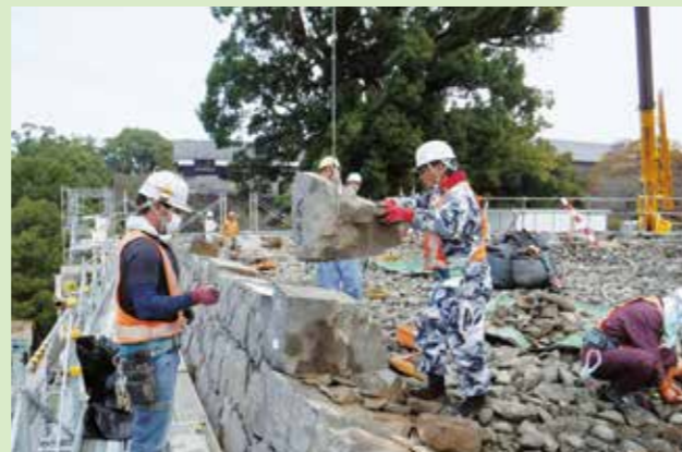
石垣解体作業 H30(2018) 11月
