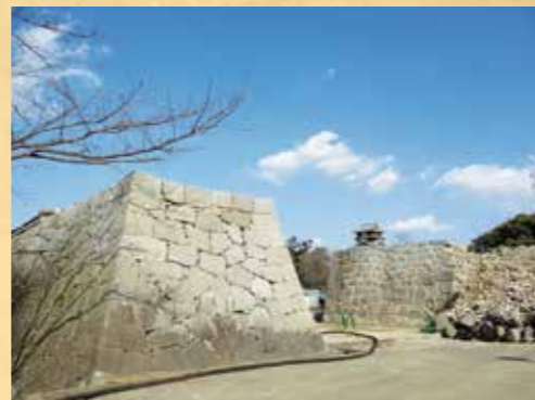
解体終了 H31(2019)3月
