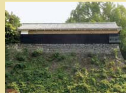
被災状況 H28(2016) 4月
