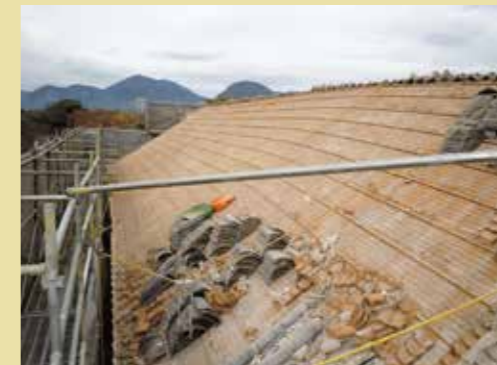
屋根瓦回収作業 H30(2018) 11月
