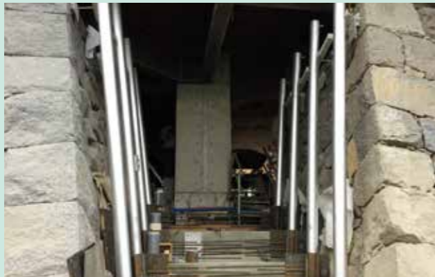
大天守出口安全対策 H31(2019) 2月
