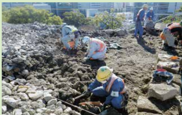
石垣裏グリ石解体 H30(2018) 11月
