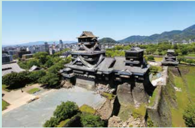
被災状況 H28(2016) 4月
