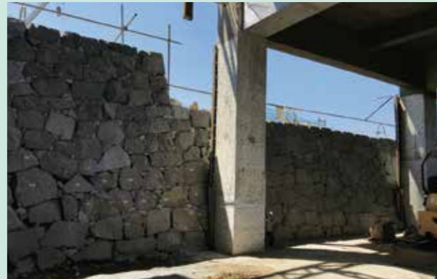
小天守内部石垣積み直し H31(2019) 2月
