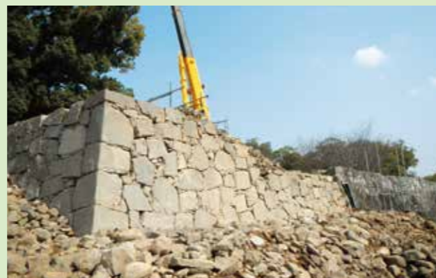
埋没石垣検出状況 H31(2019) 3月
