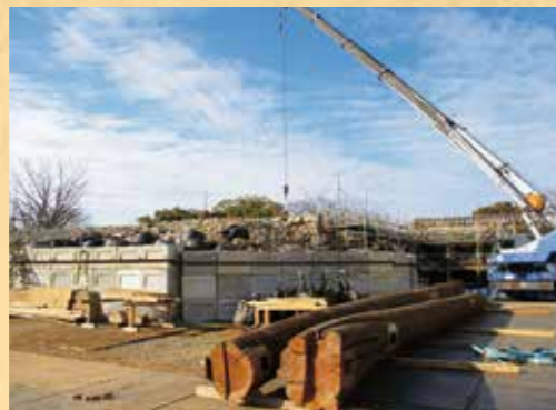
西大手門解体 H31(2019)1月
