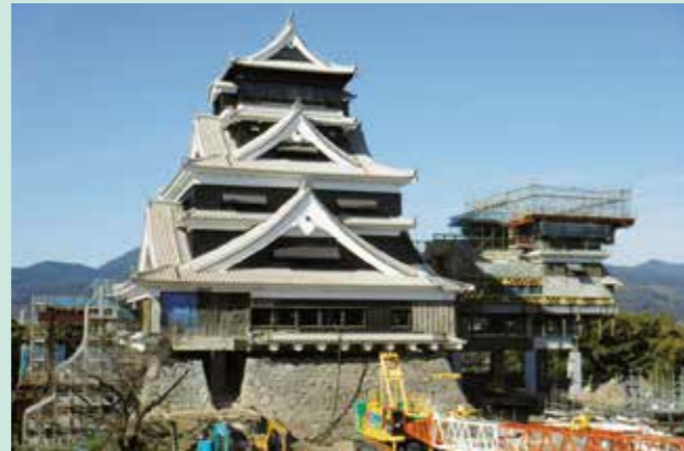
工事の状況 H31(2019) 1月
