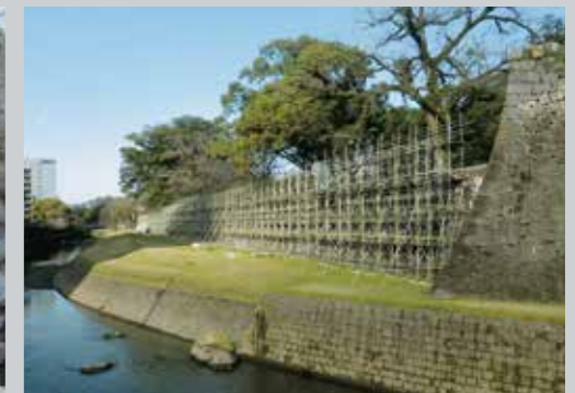
復旧工事中 H31(2019) 3月
