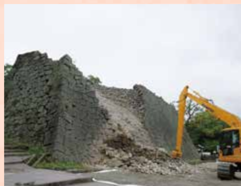
崩落石材回収作業 H30(2018)5月
