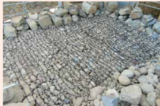
小天守石垣補強材敷き込み状況（平成31年4月22日）
