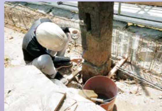
控柱の補修作業（令和元年8月2日）
