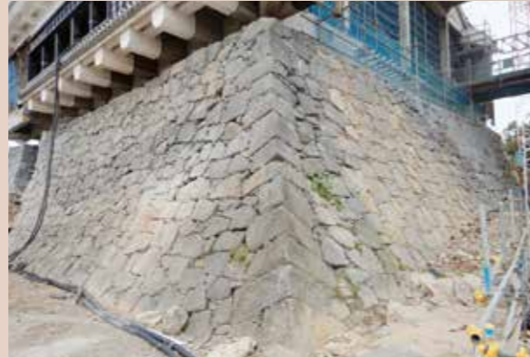
大天守石垣積み直し完了（平成31年1月8日）
