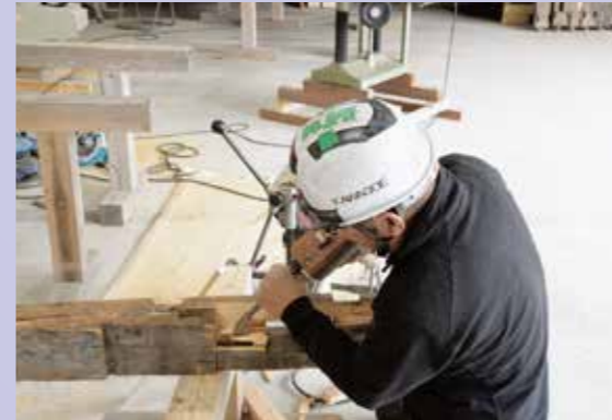
破損部材の補修作業（平成31年4月18日）
