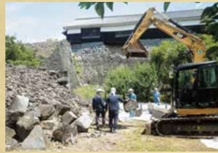
西櫓御門崩落石材回収 奥は数寄屋丸二階御広間（令和元年6月13日）
