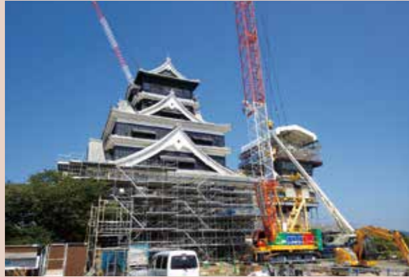
小天守最上階に仮設屋根を設置（令和元年6月25日）
