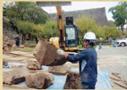
地蔵門石垣崩落石材回収 奥は二様の石垣（令和元年7月24日）
