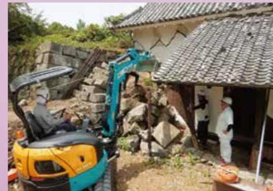
石材回収作業（令和元年8月5日）
