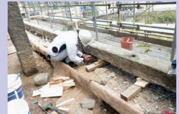
堀基礎石設置作業（令和元年8月8日）
