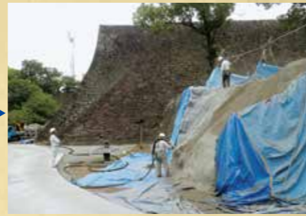
モルタル吹きつけによる安全対策工事 奥は二様の石垣（令和元年6月21日）
