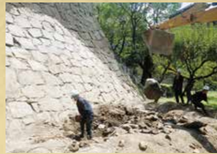
地蔵門石垣崩落石材回収 （令和元年7月26日）
