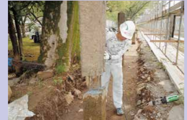
控柱の補修作業（令和元年7月5日）
