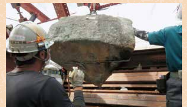
築石同士の接点確認作業状況（令和2年10月19日）
