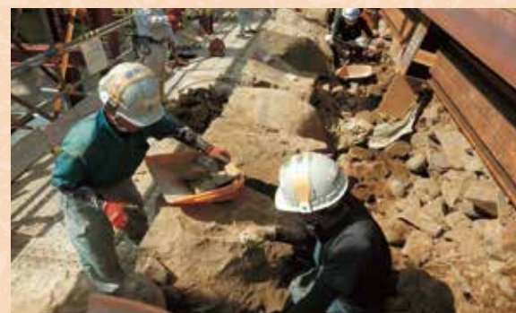
解体作業状況（令和2年10月5日）
