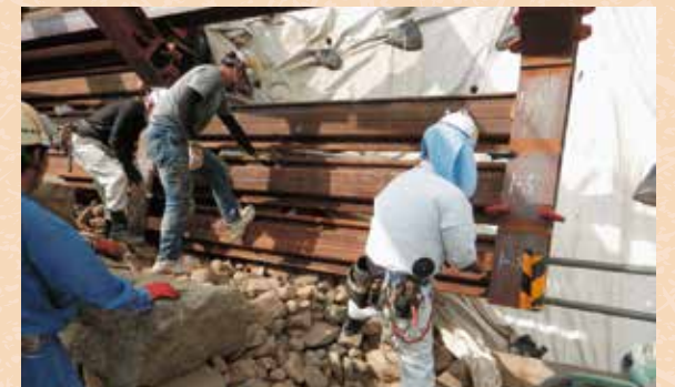
土留め矢板設置作業状況（令和2年10月5日）
