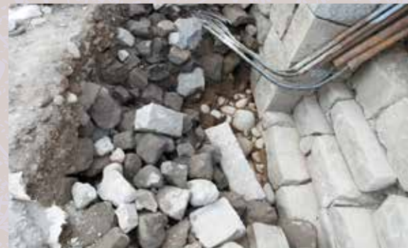
根石・基底部確認状況 東から（令和2年12月21日）
