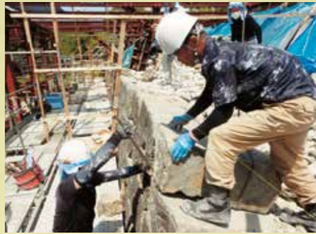
積み直し状況 (令和3年6月25日)
