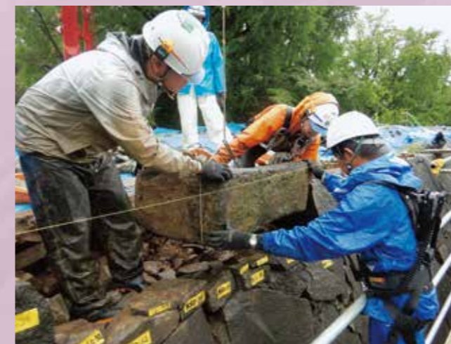
石垣積み直し状況（令和3年9月14日）
