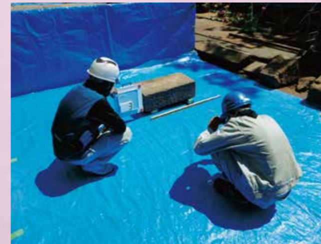
石材調査状況（令和3年7月27日）
