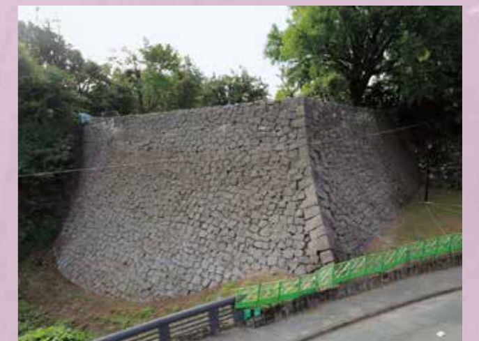
復旧完了状況（令和3年10月8日）
