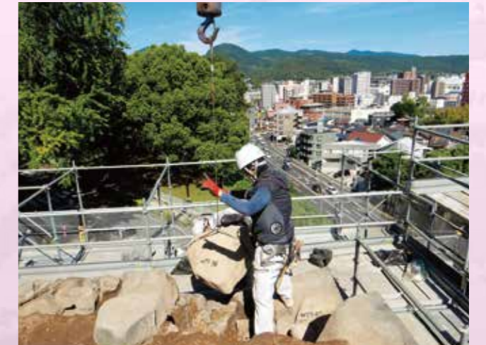
石垣解体状況（令和3年8月4日）
