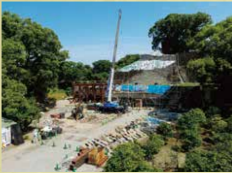
要人櫓台石垣遠景 (令和3年6月21日)
