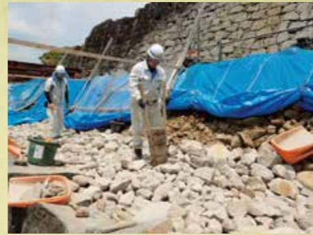
裏込め締り締め状況 (令和3年6月24日)
