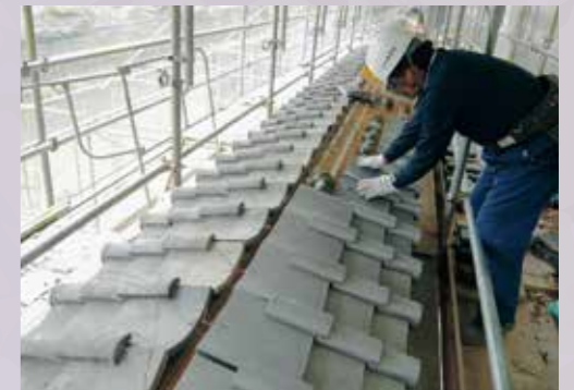
瓦葺き作業 (2020年4月13日)
