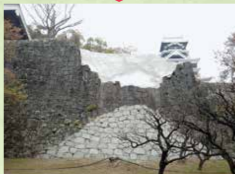
対策：崩落面をモルタルで吹き付け （2020年3月26日）
