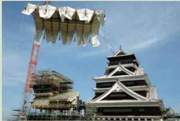
小天守仮設屋根の撤去 (2019年11月7日)
