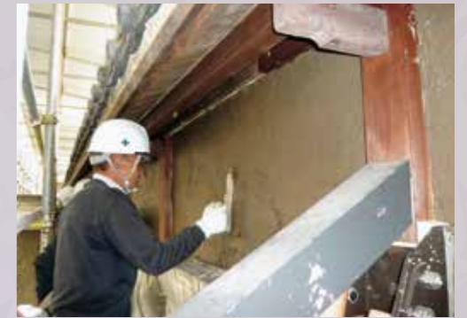
土壁塗り作業 (2020年4月2日)
