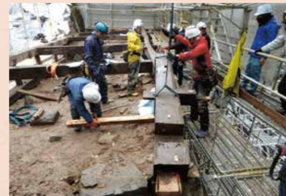
建築部材解体作業 (2019年12月26日)
