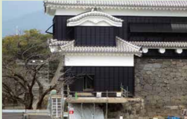
附櫓外観完成 (2020年1月9日)
