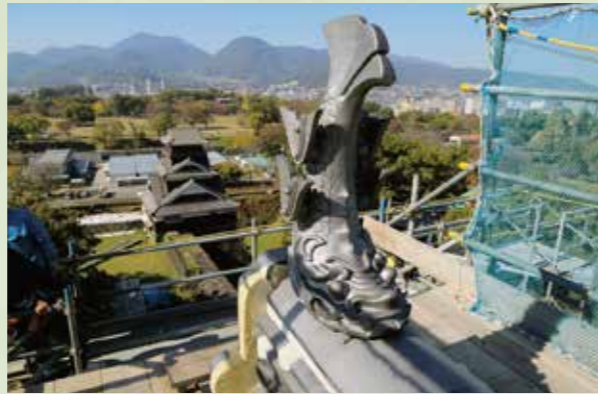
小天守鯨瓦設置完了 (2019年11月25日)
