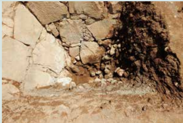
櫓台石垣の基底部を確認 (2019年7月8日)
