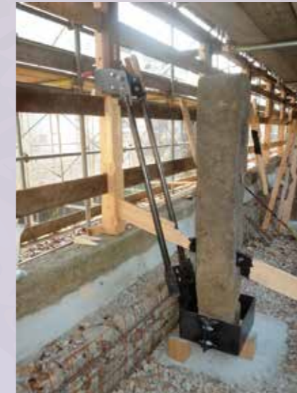
筋交い設置作業 (2019年8月8日)
