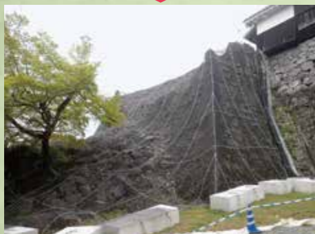
対策：樹脂製ネットで覆う （2020年3月26日）
