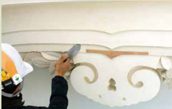
附櫓の漆喰仕上げ作業 (2019年12月16日)
