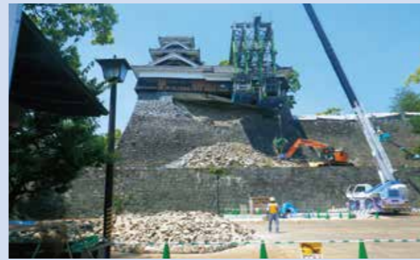
H29.5.18 崩落石材を無人重機で回収 南より
