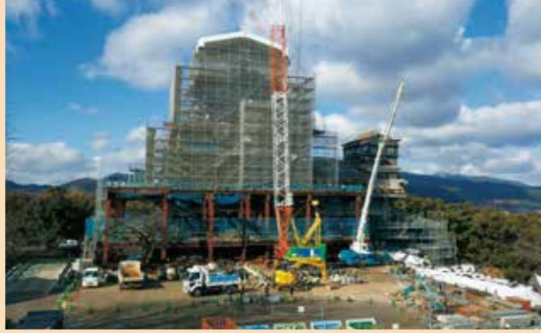
H30.1.26 天守閣工事 東より
