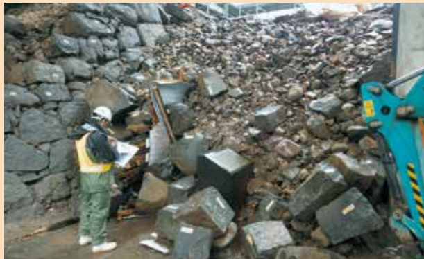
小天守内側石垣崩落石材番付作業
