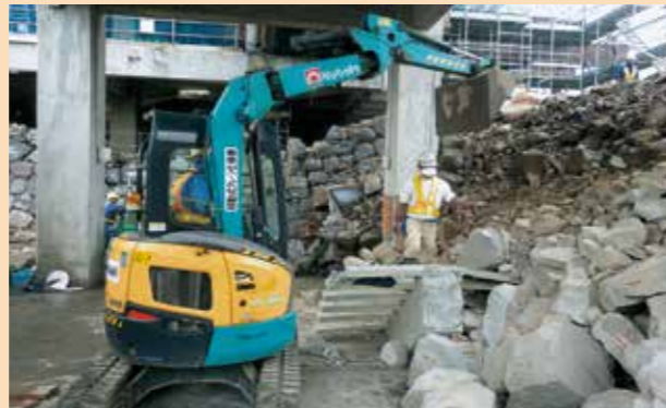
小天守内側石垣崩落石材回収作業
