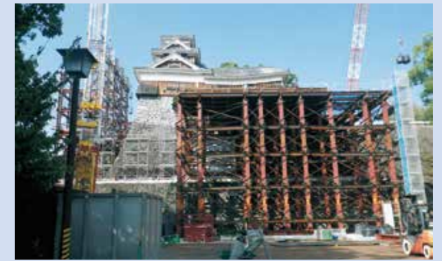
H29.10.27 下からの構台を建設後、上の構台を撤去 南より
