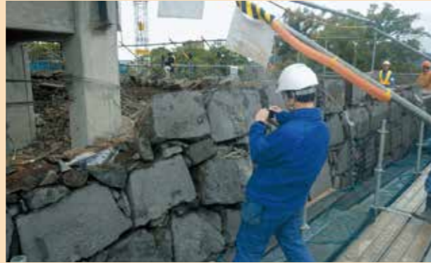
小天守石垣解体前写真記録作業
