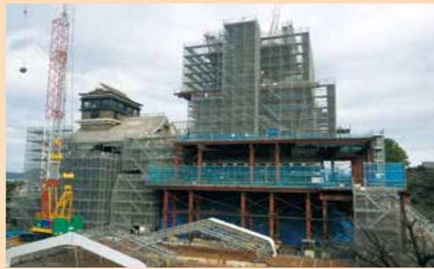
H29.10.27 天守閣工事 西より
