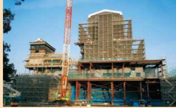
H30.2.20 天守閣工事 西より
