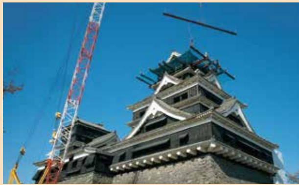
H29.4.14 天守閣工事 西より
