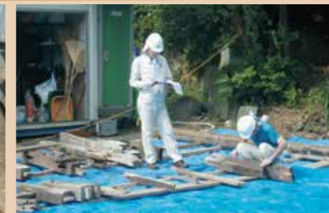
部材対照作業
