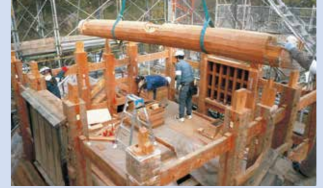
建物部材回収作業
