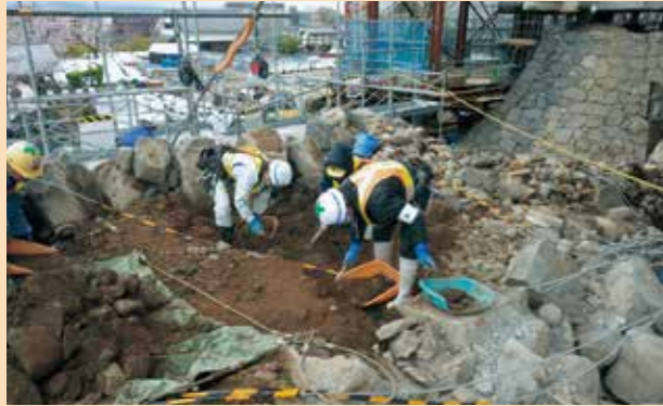
小天守石垣解体作業（裏込め掘削）
