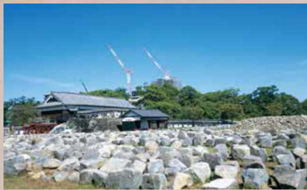
崩落した石材の保管
