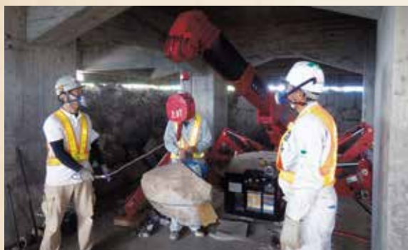
大天守内側石垣石材回収作業
