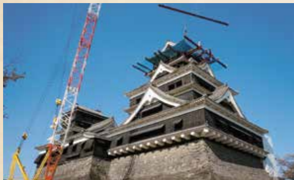
鉄骨組立作業
