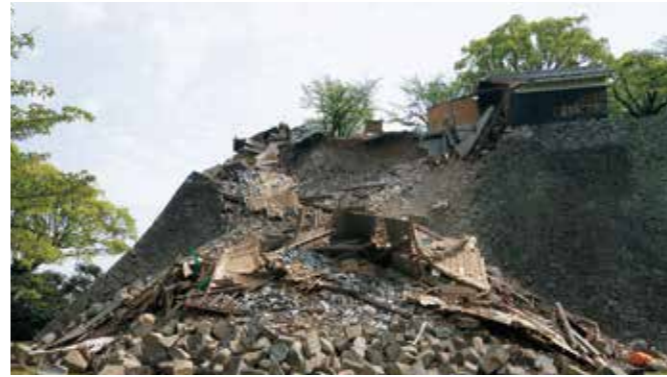
④北十八間櫓 石垣崩壊による櫓倒壊
