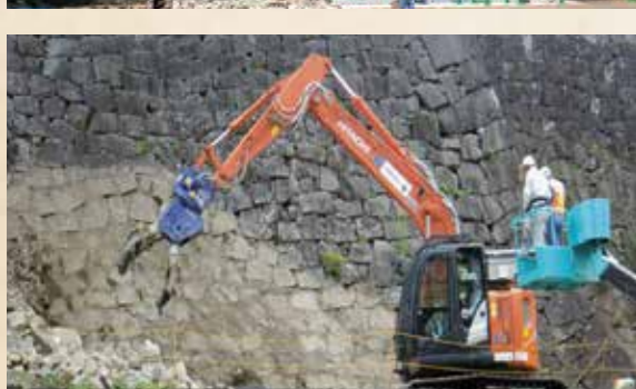
無人化重機による石材回収
