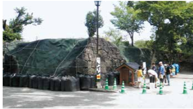
石垣石材を回収し、安全対策終了
