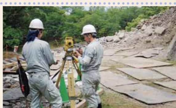
崩落石材測量作業
