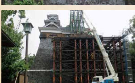
倒壊防止受構台の建設
