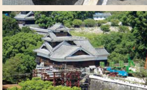
仮受構台撤去作業(市役所14階から)
