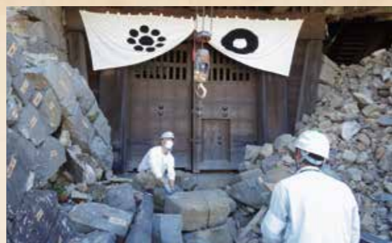
小天守入口付近石材回収作業
