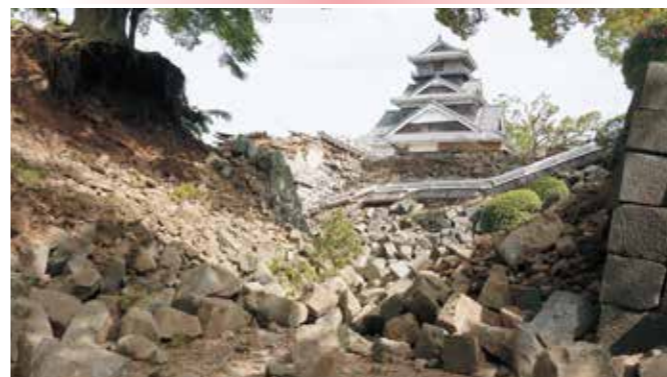
③頼当御門周辺 通路両面の石垣崩落
