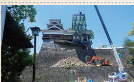
崩落石材の回収作業
