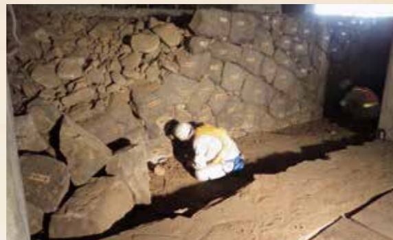
大天守内側石垣墨打ち、番付作業
