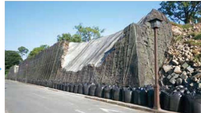
安全対策も終了し、通行再開
