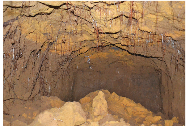
北区第2号地下式坑室部（南から）
