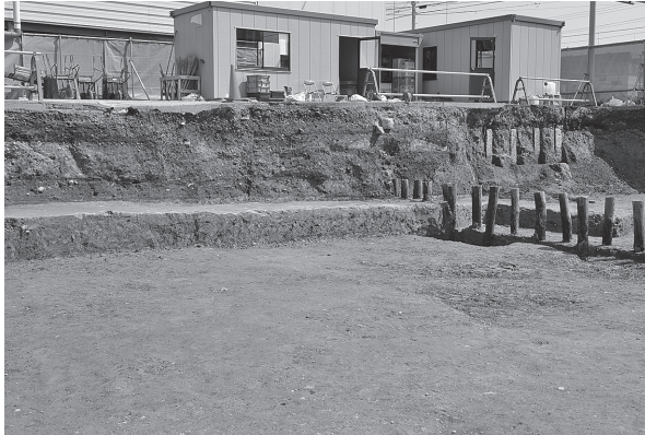
II区東壁土層南側（北西から）
