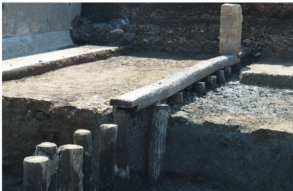
Ⅱ区第1号近代礎石建物構築状況（西から）
